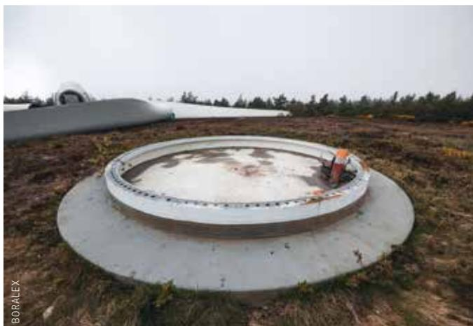
*Un arrêté du 22 juin 2020 impose le retrait de l'intégralité des fondations des éoliennes, sauf si le bilan environnemental du décaissement total est défavorable. Dans ce cas, les fondations doivent être excavées d'au moins deux mètres sur terrain forestier et d'au moins un mètre ailleurs.*
