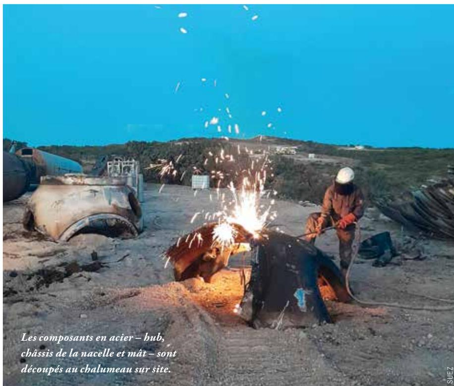
*Les composants en acier – hub, châssis de la nacelle et mât – sont découpés au chalumeau sur site.*
