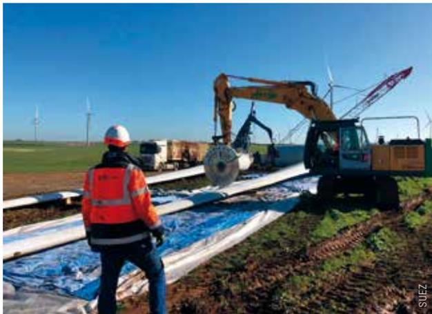
*Le sol est protégé, les poussières de découpe sont plaquées au sol par l'eau injectée sur la scie circulaire. La pale est découpée de telle sorte que les tronçons puissent être chargés dans la remorque d'un camion.*
