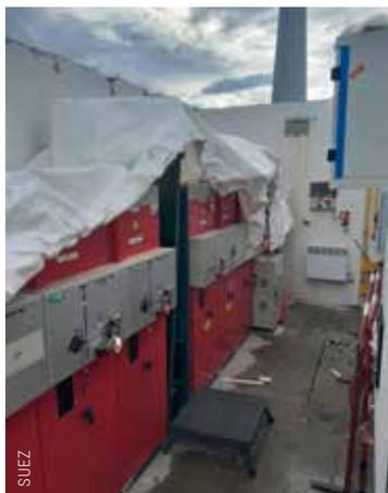
*Le poste de livraison électrique est également démonté pièce par pièce et vidé de son contenu.*
