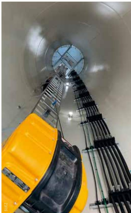
*L'intérieur du mât contient différents composants : échelles et plateformes métalliques, luminaires, câbles.*
