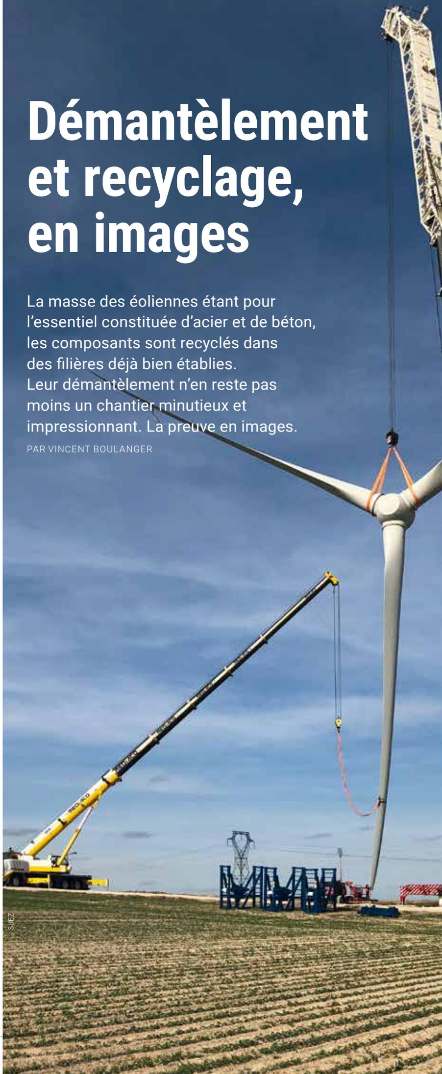
*Avant d'engager le démantèlement de l'éolienne, les chemins d'accès et les plateformes de démontage doivent être refaits pour accueillir les engins. Ensuite, des sociétés spécialisées déposent au sol des composants de l'éolienne, rotor, nacelle, sections de mât. Suivant sa taille, il faut 2 à 7 jours pour démonter une éolienne.*
