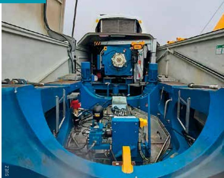
*La nacelle doit être démontée pièce par pièce, générateur, armoire électrique et autres. Les composants encore en bon état, boîte de vitesse par exemple, peuvent être revendus sur le marché de l'occasion. Les déchets dangereux (huiles, liquide de refroidissement, etc.) sont placés dans des conteneurs sécurisés pour être évacués.*
